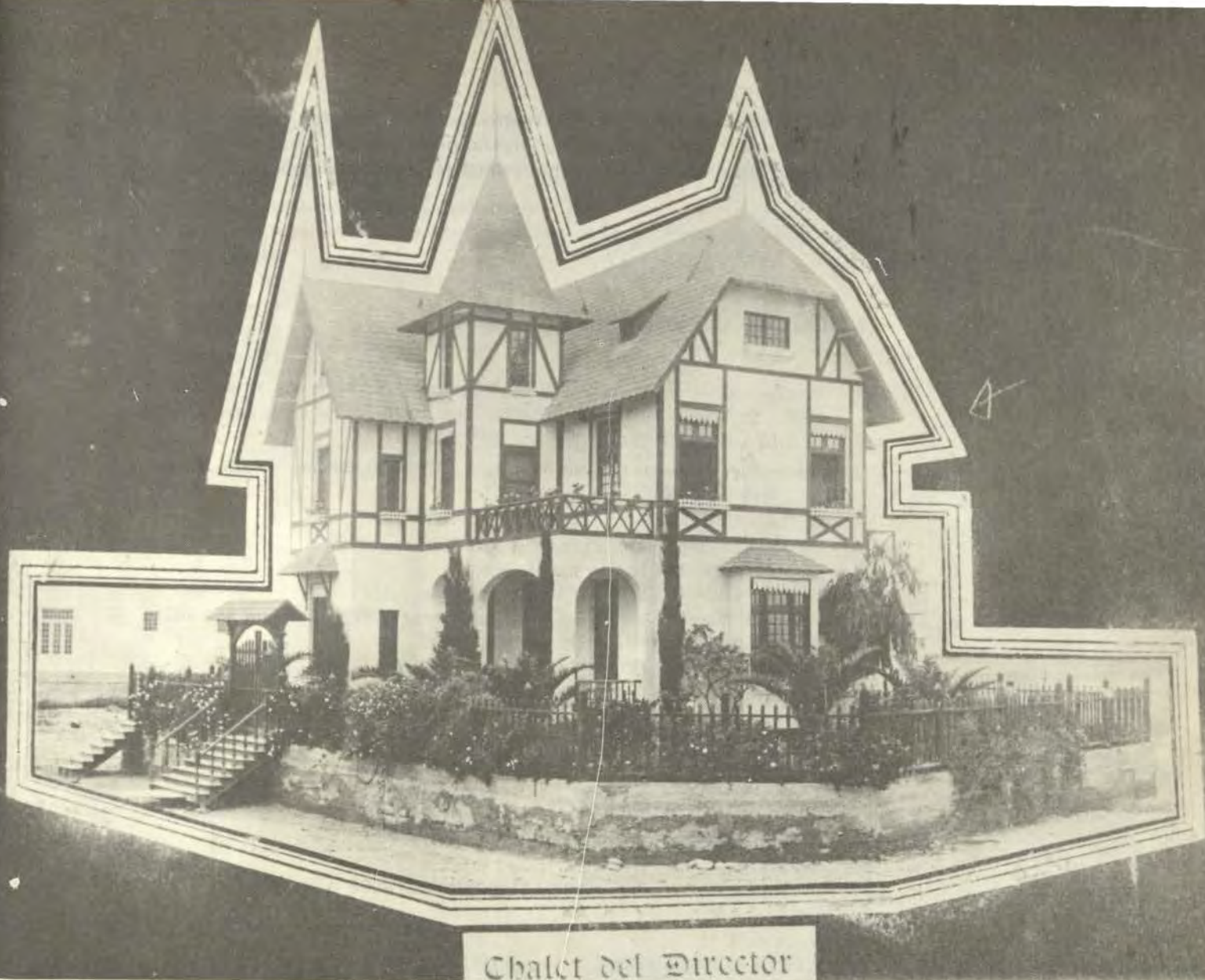
Chalet del Director. Se mantuvo en esa forma hasta la década de 1960, en que la modernización de la Escuela obligó a derruirlo. (E.N. del P.).
