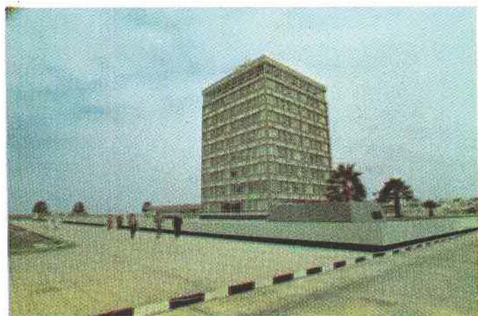
Edificio de oficiales.
