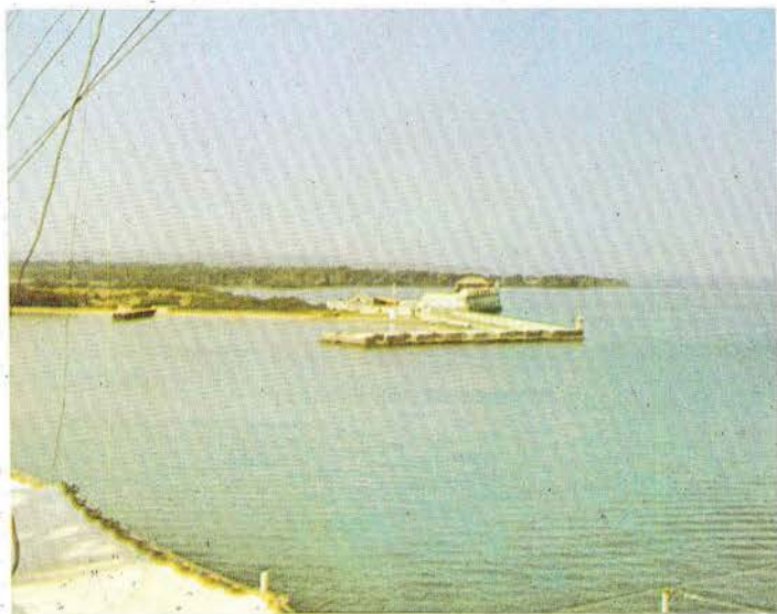
Ingreso por Boca Grande.
