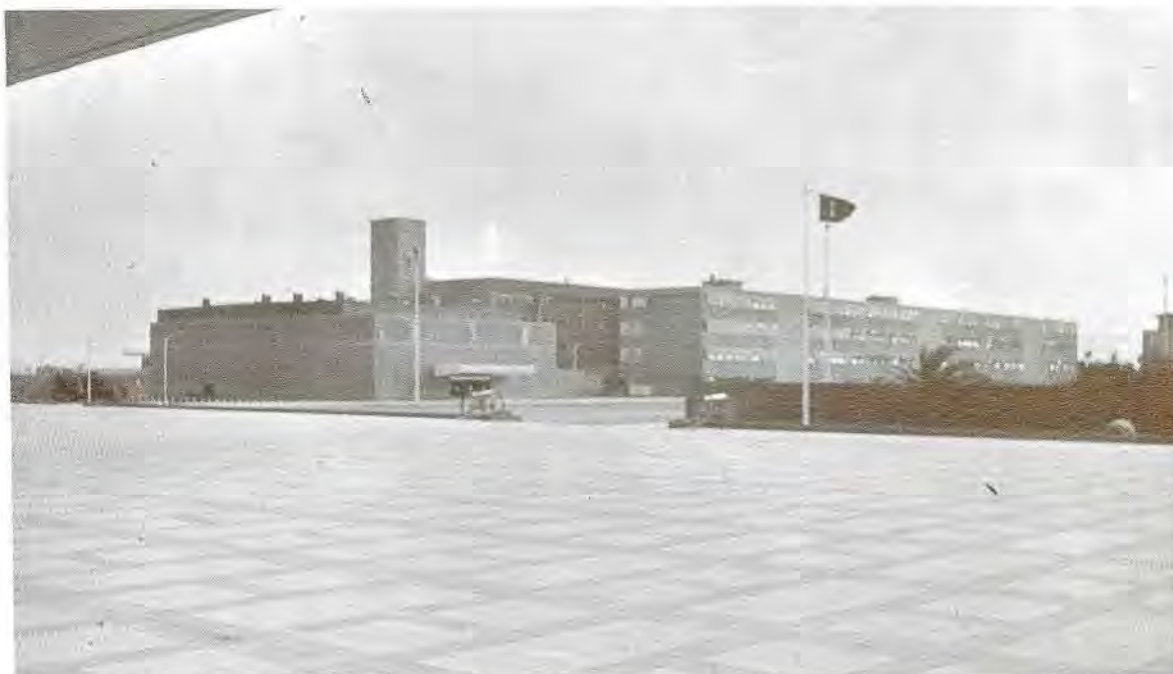
Vista Panorámica de los Edificios Académicos y Auditorio de nuestra Escuela.
