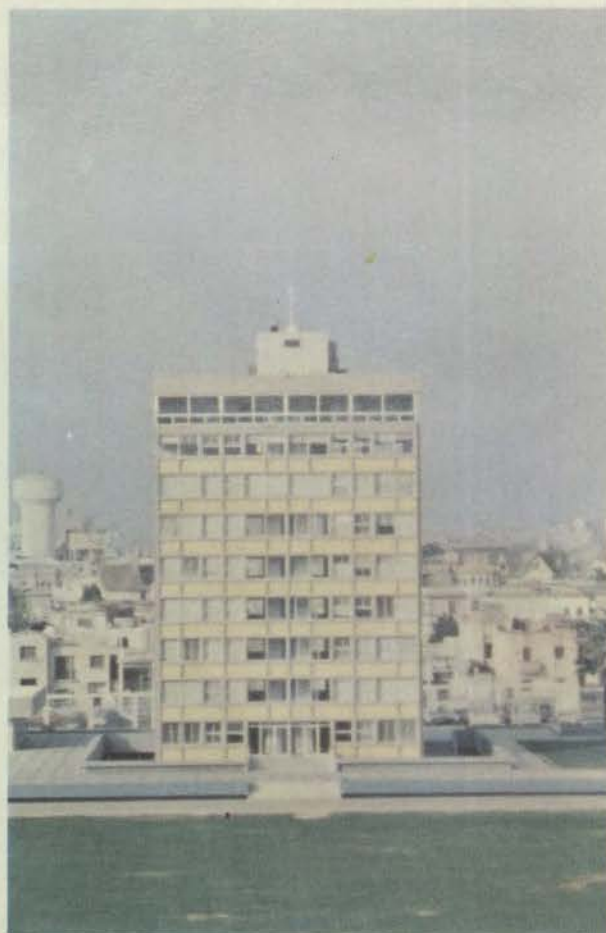
Edificio de Oficiales
